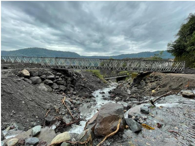
**Imagen 5 - Montaje del puente tipo Bayle sobre el río Piedra Fina, al fondo se observa el puente de hormigón colapsado**
