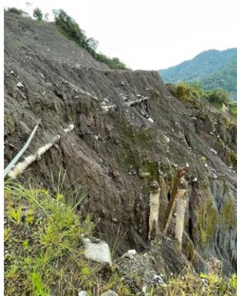
**Imagen 7 - Colapso del SOTE producto de la erosión regresiva del río Coca.**
